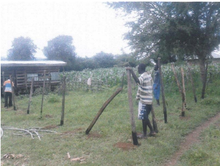
Das fertige Feld mit Umzäunung
